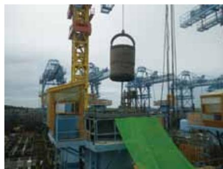
写真－7 土砂バケット吊上げ状況
