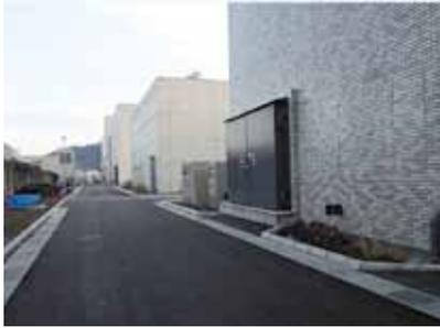
写真：気仙沼市気仙沼終末処理場（管理本館・沈砂池ポンプ棟）地下ポンプ室（揚水機能の確保）の津波・浸水対策として地上1階は、耐水扉の設置と窓閉塞を行った。
