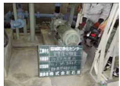
電動機の絶縁抵抗の測定
