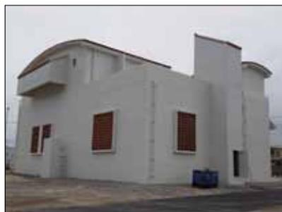
写真：石垣市八島汚水中継ポンプ場（津波による浮力を考慮しグラウンドアンカーを設置している。）
