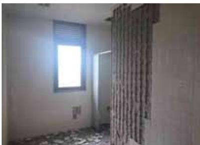
写真：益城町浄化センター被災状況（トイレタイルの剥落）
