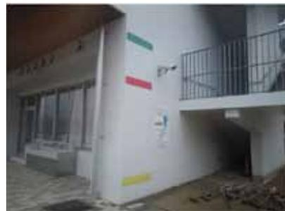
写真：東京都内小学校の過去の浸水高を表わしたマーク。屋外階段横にあり、過去被害を色分けし判り易いものとしている。（浸水は避けられないが、避難の目安にはなる。）
