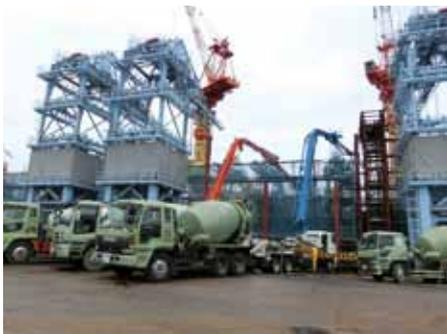
写真－3 コンクリート打設状況（ポンプ車）
