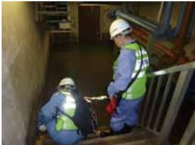
写真：益城町浄化センター被災状況（管廊水没）
