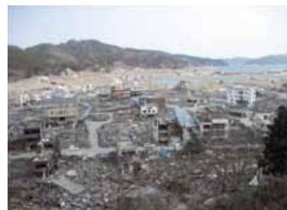
写真：旧大槌町役場周辺の津波被害状況（木造建築物は、倒壊、流されていた。）
