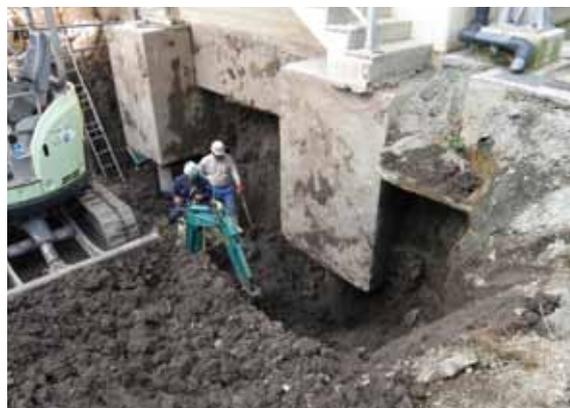
写真：益城町浄化センター汚泥処理棟の追加調査（杭の被災状況を確認し、建物をジャッキアップによる工法で復旧する方針とした。）
