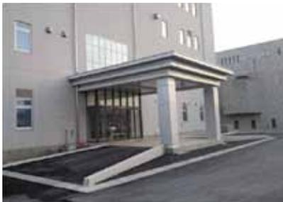
写真：気仙沼市気仙沼終末処理場（新管理本館）は浸水深さ等を考慮して、既設管理本館・沈砂池ポンプ棟（写真右奥）より1階床レベルを高い位置に設定し、電気設備は3階以上に設置している。
