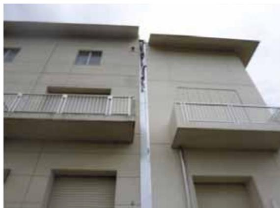
写真：益城町浄化センター汚泥処理棟の被災状況（右が増設棟）地震により建物は基準値を超えた沈下及び傾斜量であったことから、杭の被災確認の追加調査を判断した。
