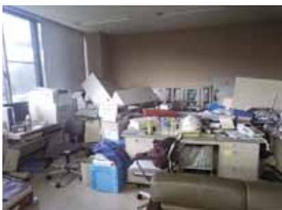
写真：事務室のロッカー倒れる（固定金具での耐震対策が必要である。）
