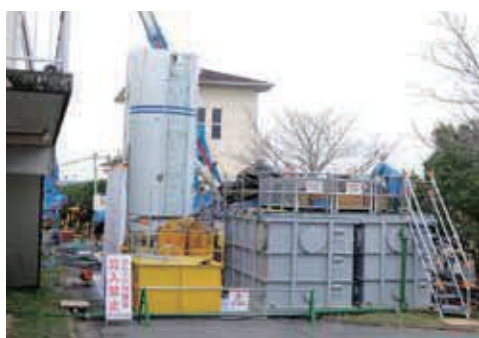
写真8 地盤改良プラント設置状況
