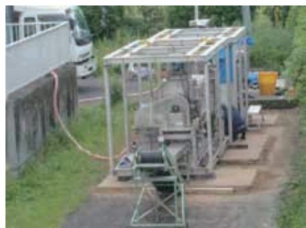
写真5 小型仮設脱水機設置状況
