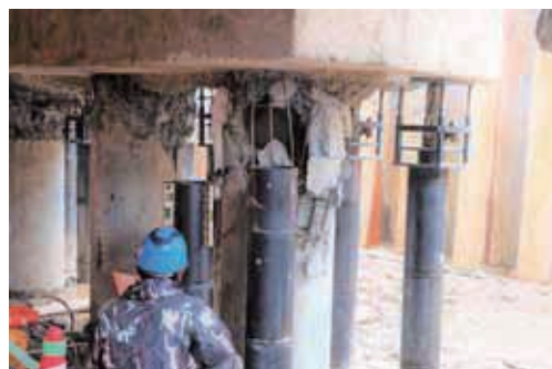
写真6 汚泥棟ジャッキアップ準備状況
