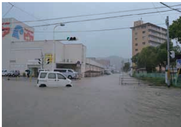
H27 年の浸水状況、これが約 30 分で解消
