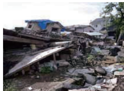
写真3 被災した家屋（益城町安永）
