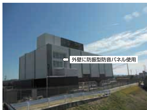
（写真5）第一種住居地域に建つ雨水ポンプ場で外壁に防音パネルを施工（騒音規制値：昼間 45dB、夜間 40dB）
