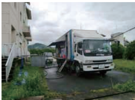
写真4 移動脱水車設置状況
