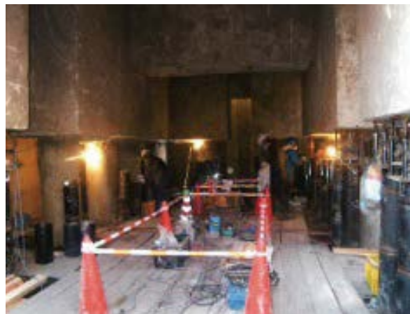
写真5 基礎下ジャッキアップ状況
