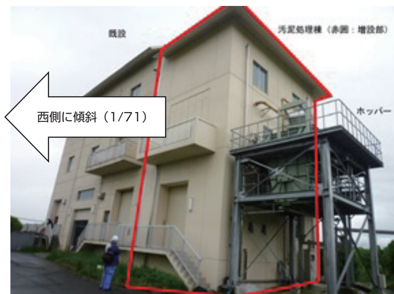
(写真 1) 汚泥処理棟 西面外観
