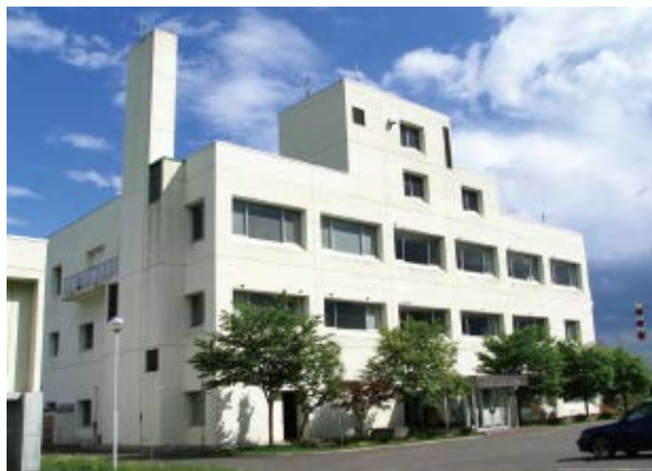
遠軽下水処理センター
