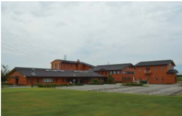
中新川広域行政事務組合（中新川浄化センター）
