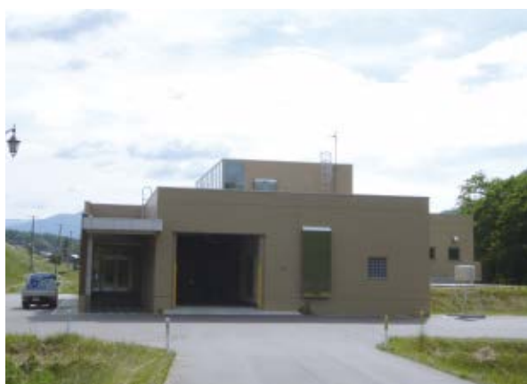
白滝浄化センター
