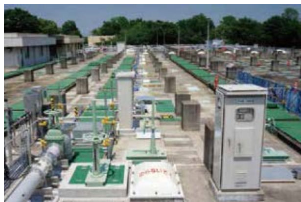
写真-1 実証施設の上部 (左: 最初沈殿池部分、右: 反応タンク部分)
