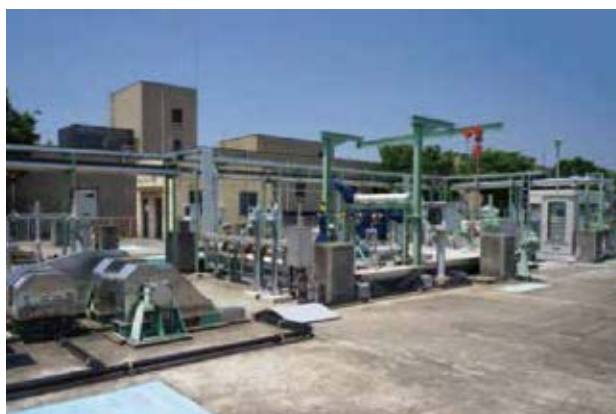
写真-1 実証施設の上部 (左: 最初沈殿池部分、右: 反応タンク部分)
