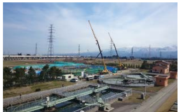
増設中（中央）の中新川浄化センター（7池目）
