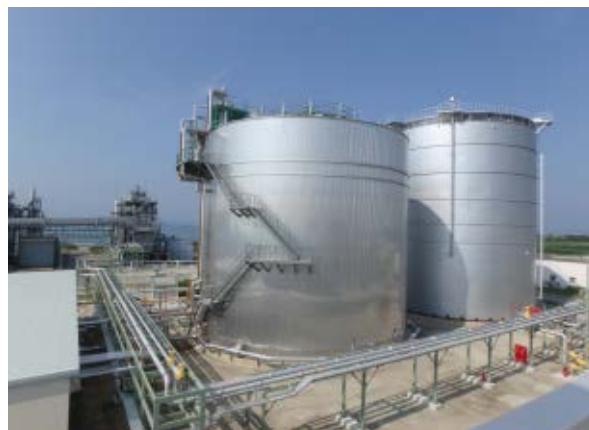
図4 消化施設全景
