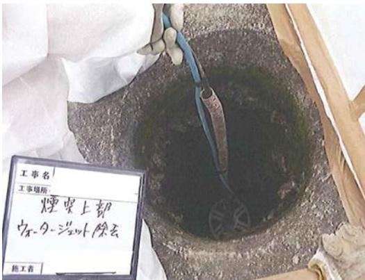
写真4-3 煙突上部除去状況
