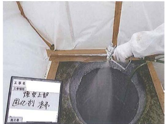
写真4-5 除去後の固化材塗布状況
