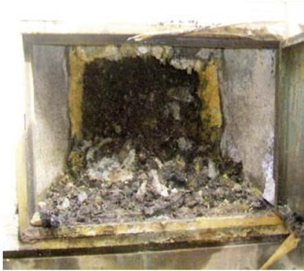
写真2-2 点検口内部の脱落した断熱材
