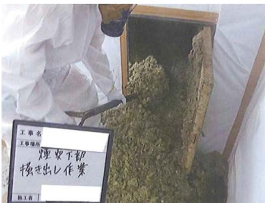
写真4-4 石綿含有断熱材掻き出し状況
