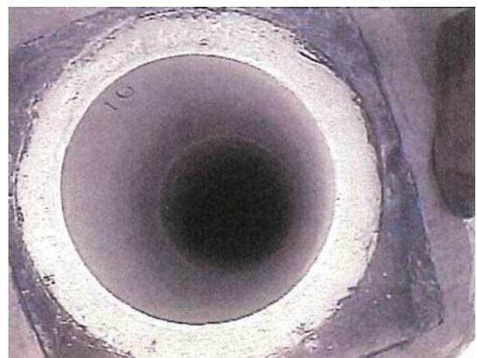
写真4-7 無石綿ライニング材挿入完了
