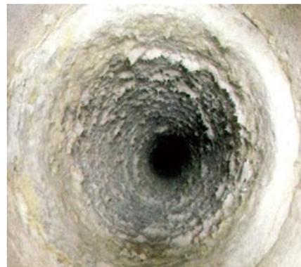
写真2-1 煙突内部の劣化状況
