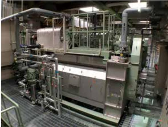
図-6 小諸浄化センターに導入した圧入式 SP (Ⅲ型)
