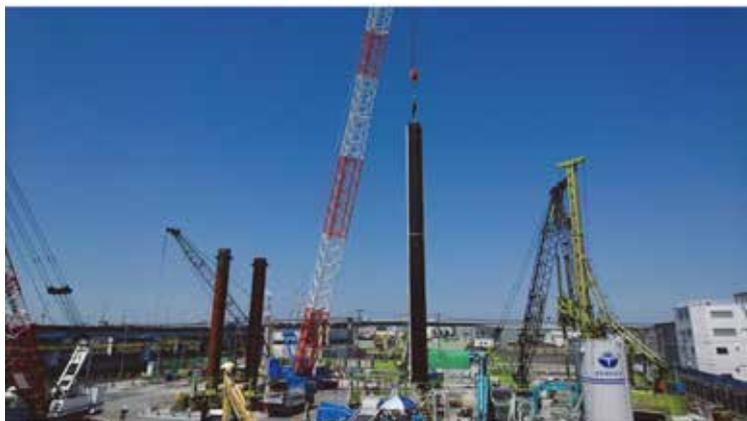
古川第2ポンプ場の工事状況（鋼管の打設状況）
