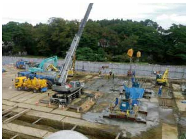
写真-1 地盤改良施工状況
