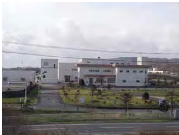
若山浄化センター
