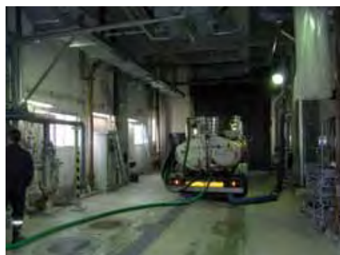
し尿投入施設
