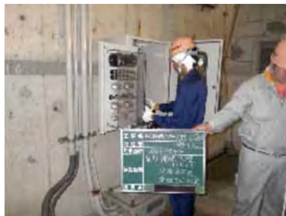
写真6 制御盤復旧作業（床排水ポンプ用）
