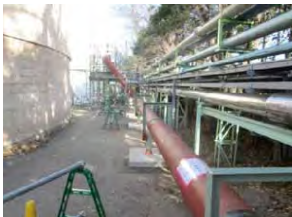
写真2 汚泥圧送配管敷設
