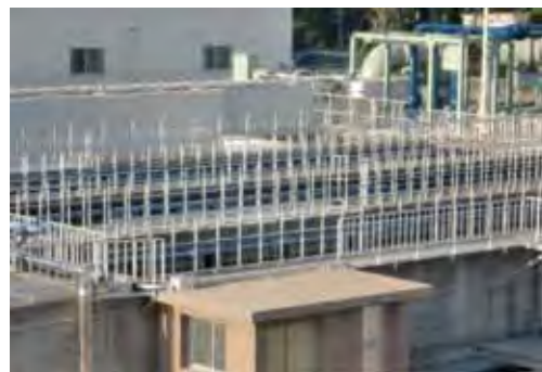
写真2 滞水池、高速ろ過施設
