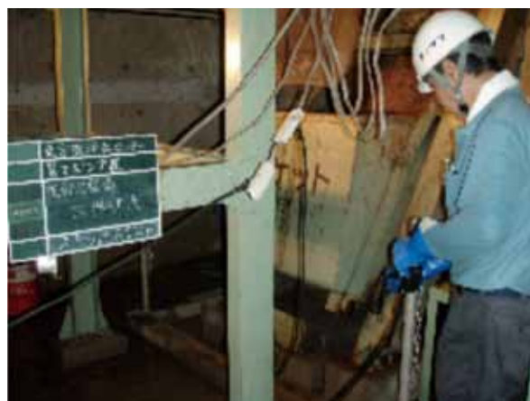
写真4 機器仮復旧作業（スキップホイスト）
