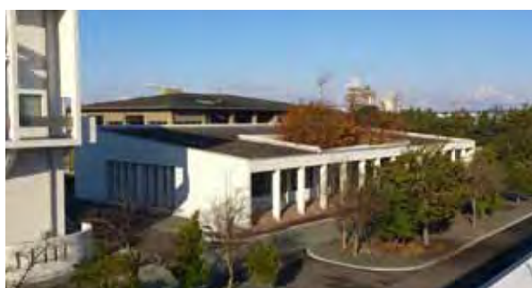
松前町浄化センター管理棟
