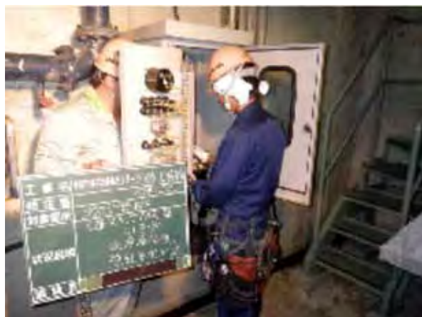
写真5 制御盤復旧作業（スキップホイスト用）
