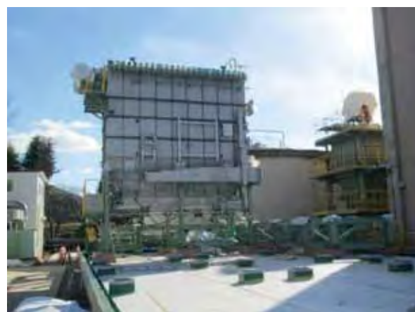
写真1 乾燥設備基礎と集塵装置
