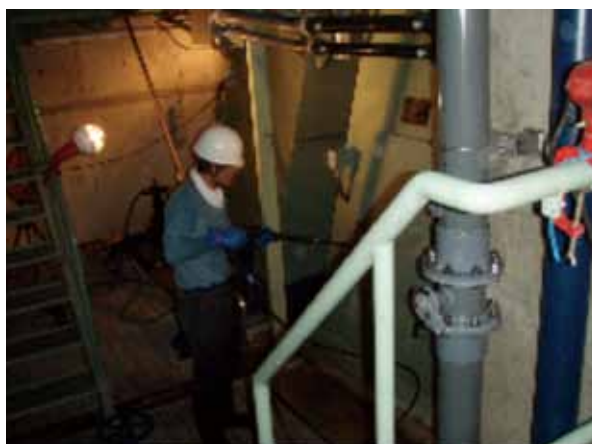
写真3 機器仮復旧作業（自動除塵機）
