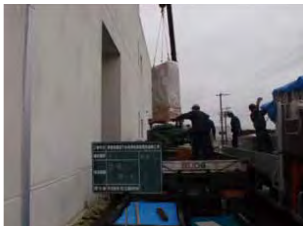
写真－4 盤搬入状況
