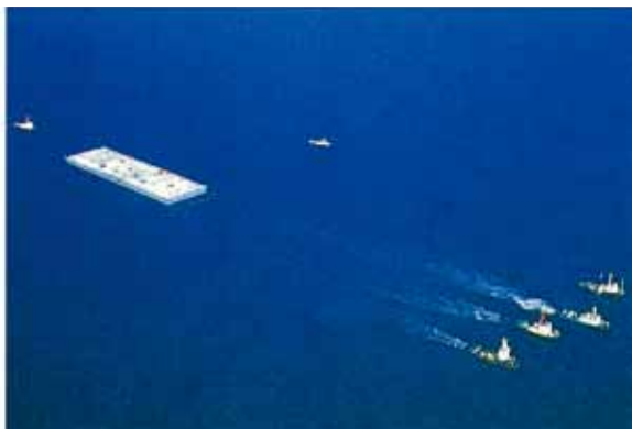
鋼殻体の海上輸送（約 20 曳航時間）
