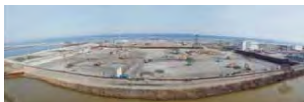
南蒲生浄化センター（既設水処理施設 撤去完了）
