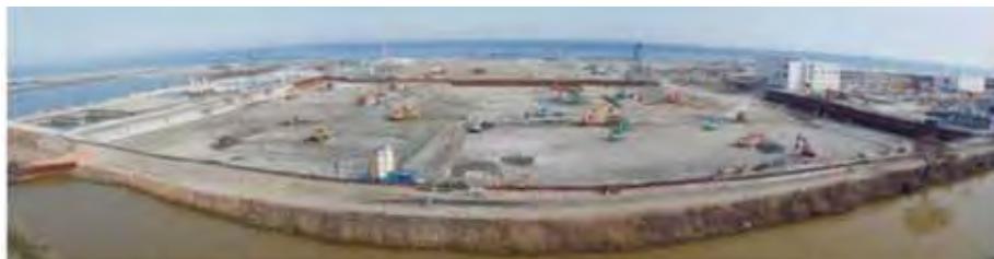
新水処理施設の建設が進む南蒲生浄化センター（H25.3）管理棟側→太平洋
