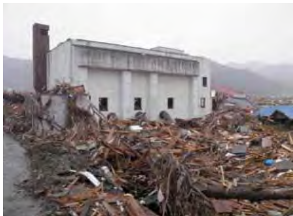
鵜住居雨水ポンプ場
