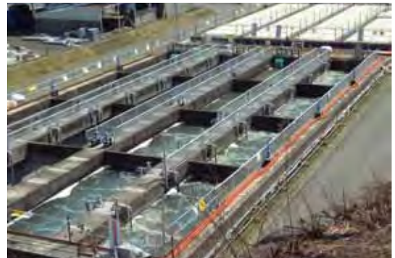
再開した釜石市大平下水処理場
