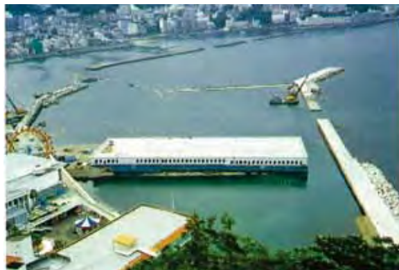
鋼殻体据付・上屋建方完了
