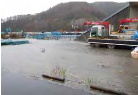
豪雨により冠水するポンプ場
