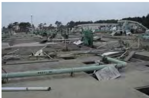
県南浄化センター 水処理施設（復旧前）
