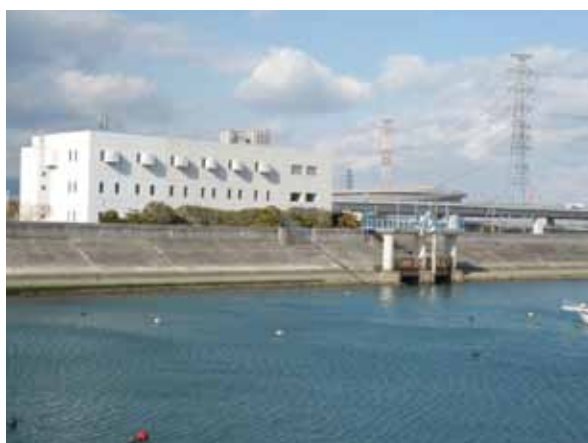
川越排水機場
