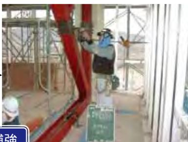
枠付き鉄骨ブレースによる耐震補強
