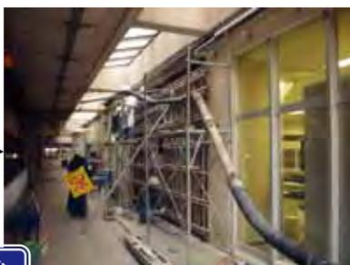
RC耐震壁の増設による耐震補強
