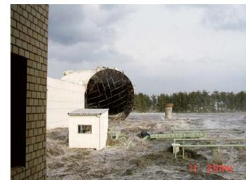
図6 浮力による転倒事例
