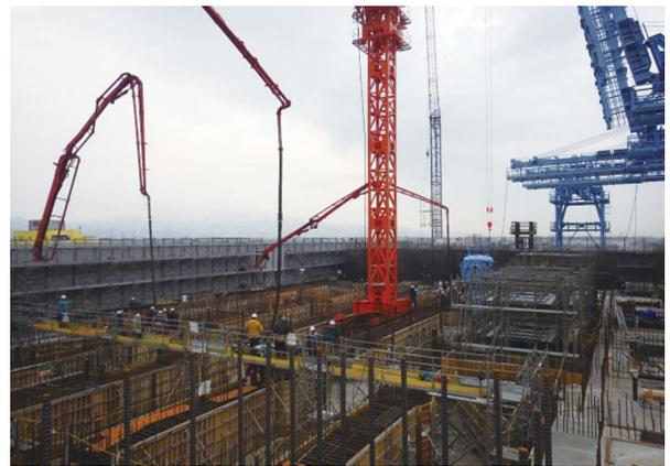
写真-2 コンクリート打設 (H26.11.22)
