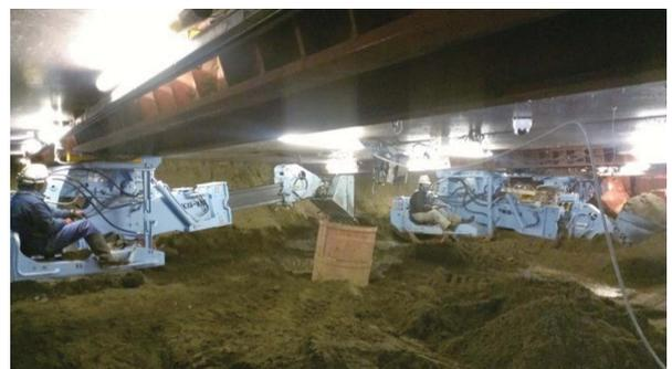
写真-4 ケーソン内掘削状況 (H26.12.5)
