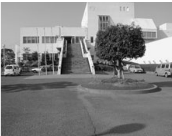
①現状写真（正面から）
