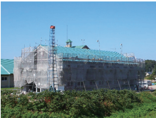
写真－５ 外足場撤去が間近の流量調整棟の全景
