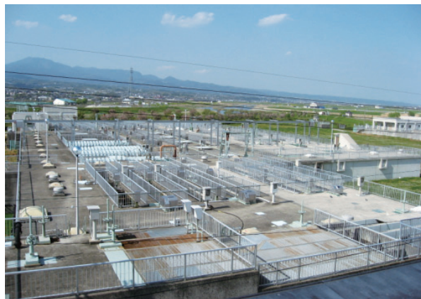
諫早中央浄化センター
