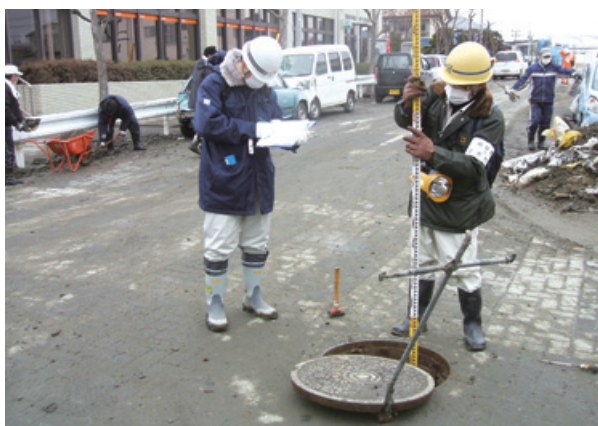
宮城県塩竈市での 下水道管渠被災調査（一次調査）状況
