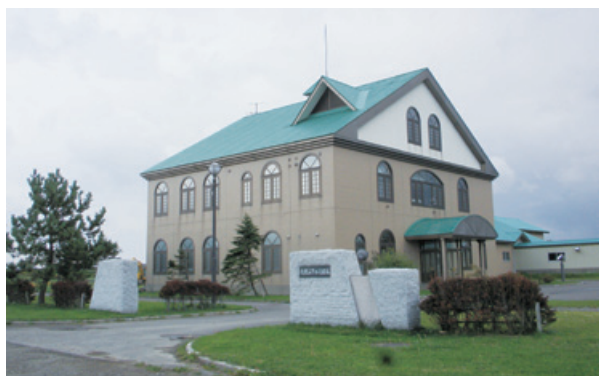
写真-1 北桧山下水処理場（管理棟）
