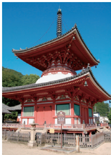
写真－1 浄土寺多宝塔
