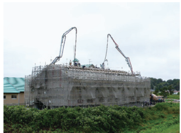
写真－４ ２階部分コンクリート打設工
