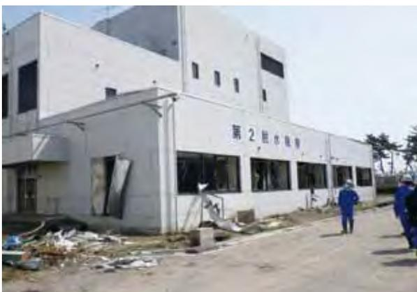
写真3 津波の流出口及び開口部の外側変形
