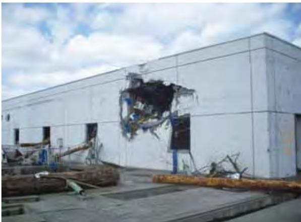
写真6 流木による壁破壊
