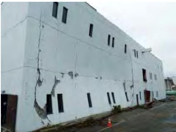
写真2 吹き抜け部の壁面の破壊
