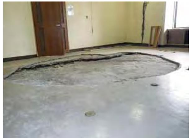
写真4 浮力による床崩壊
