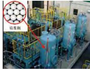
高速吸着剤を用いたリン除去・回収技術
