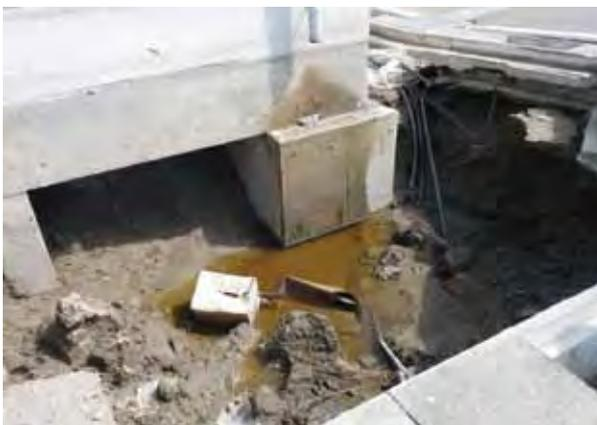
写真7 洗掘による基礎の露出
