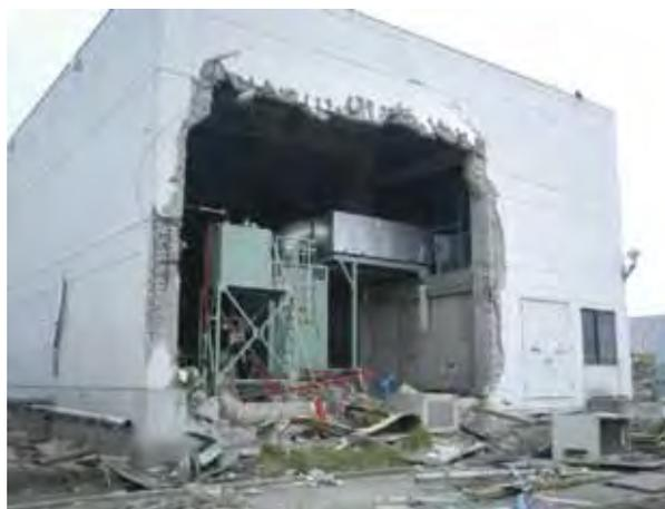
写真1 壁の破壊
