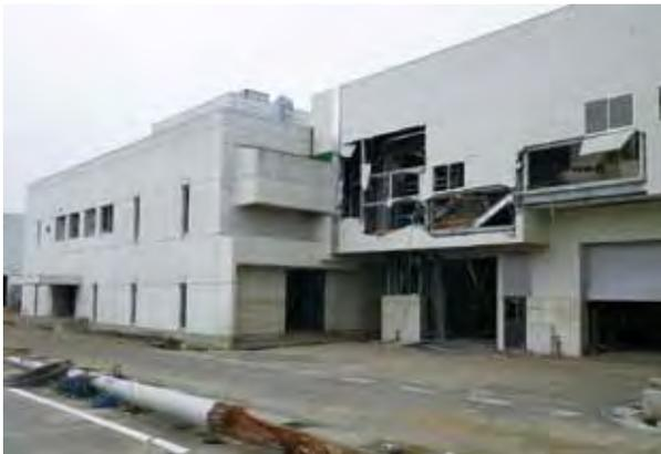
写真10 津波の流出口及び開口部の破壊
