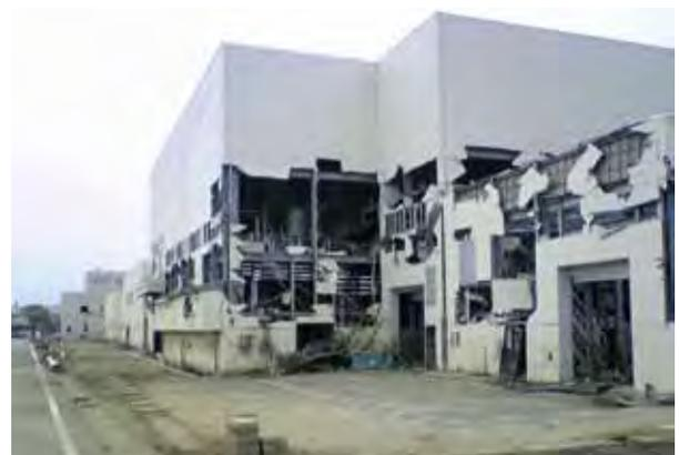
写真8 外装材の破壊・流失
