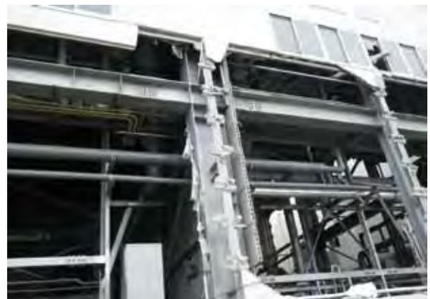
写真9 外装材の破壊・流失
