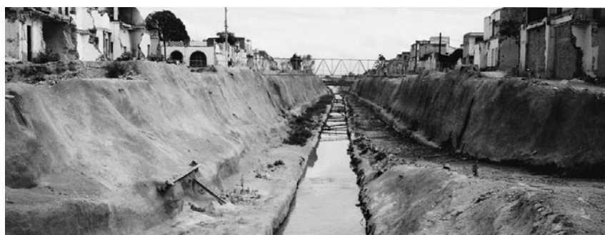
写真 グアダラハラ市における道路陥没状況
