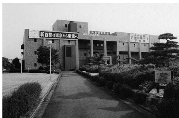
写真-1 総タイル張りの管理本館
