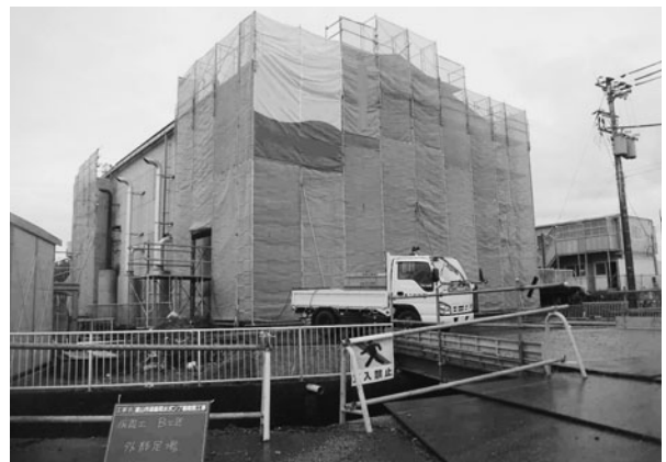
写真-2 施工中（外部足場設置状況）
