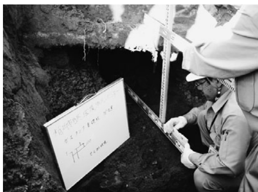
写真1 ガスタンク杭調査状況
