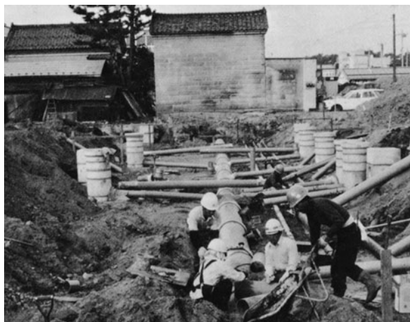
復興区画整理事業と下水道工事
