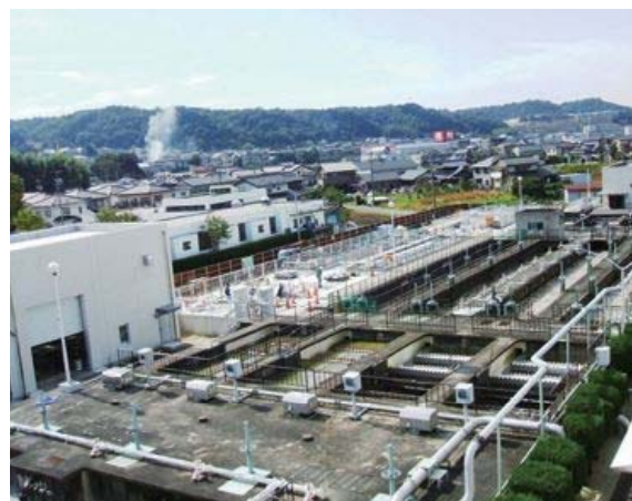
増設工事が進む浄化センター
