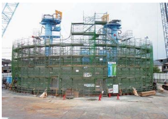
清須市助七公園調整池 工事写真
