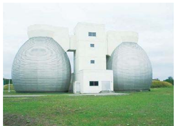
昭和61年4月に運転を開始した卵形消化槽
