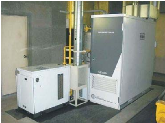
マイクロガスタービンエンジン タービンメーカー 米国キャプストーン社 発電出力 30kw
