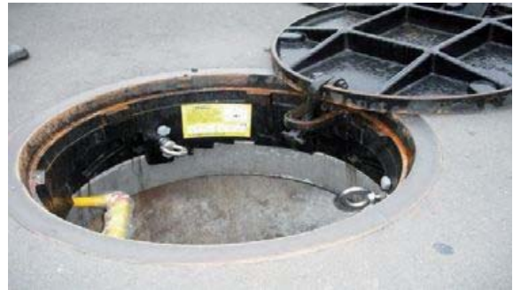
スライド式マンホール 階段式のアジャスタをスライドさせて沈下に対応する
