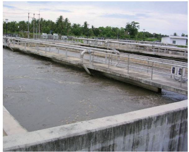
写真2 パタヤ処理場エアレーションタンク
