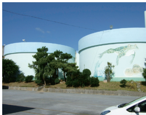
写真－2 那覇浄化センター消化槽（躯体は復帰前に築造）
