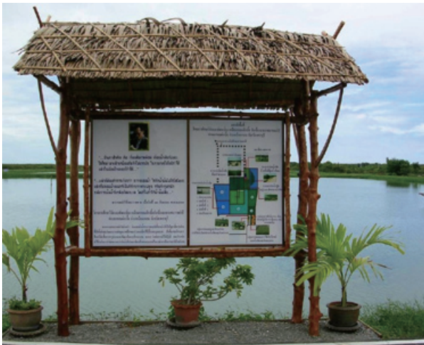
写真3 ペップリ処理場配置図（左側に国王のメッセージ）と安定化池
