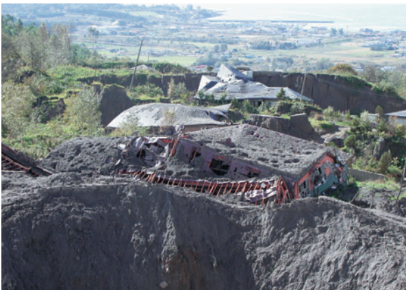
破壊された工場
