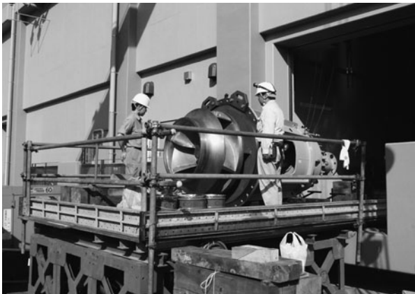
復旧したポンプの搬入
