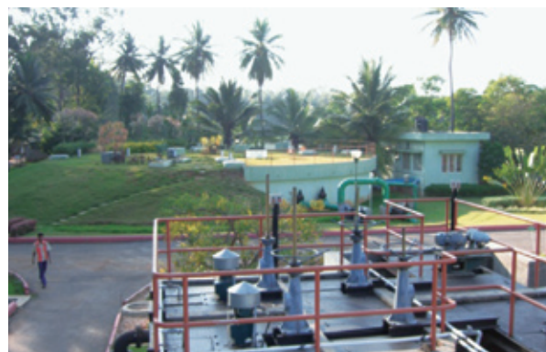
写真—1 高度処理の処理場（1.0MLD） 処理場の処理水質はBOD 5 1mg/L以下
