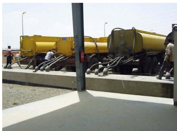
写真2 大量に投入されるセプティックタンク引き抜き汚泥
