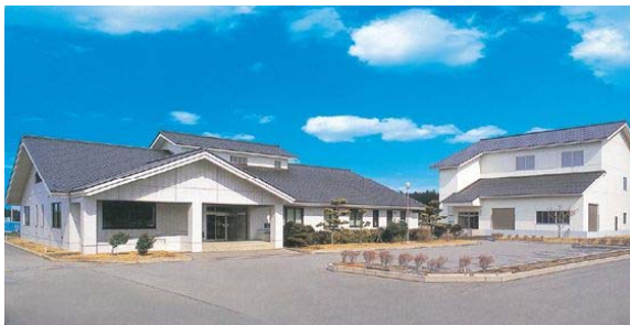
写真－4 笹森クリーンセンター管理棟・汚泥処理棟
