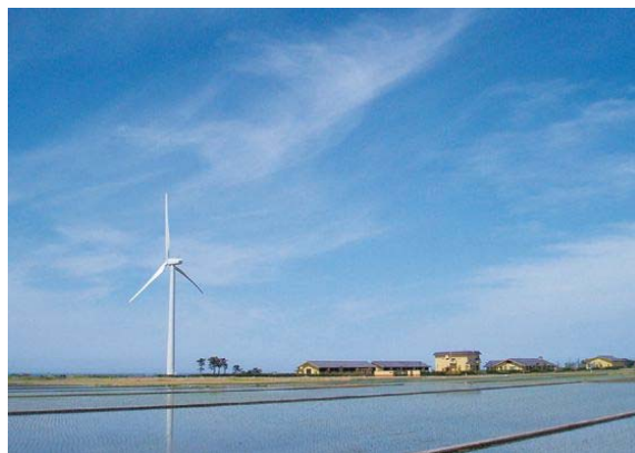
入善浄化センターの風力発電施設②
