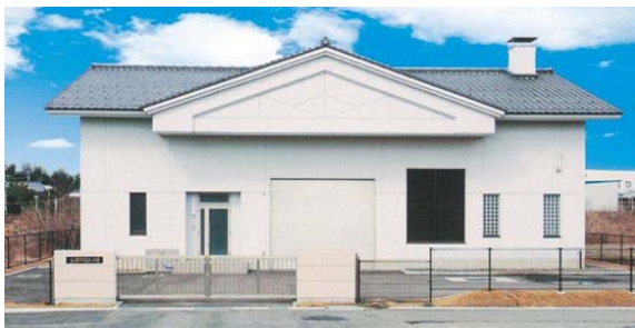
写真－5 金浦中継ポンプ場
