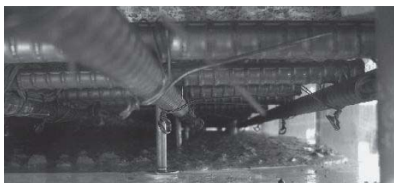
写真-2 型枠内部の耐硫酸コンクリートの流動状況 4)
