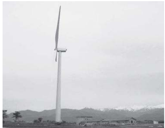
写真2 風力発電設備鉄塔
