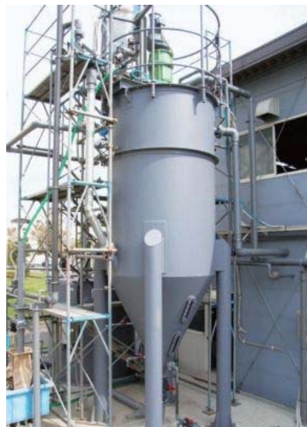
写真1 リン回収プラント(処理量 50 m 3 /d)
