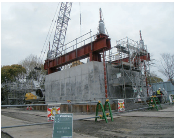
分水人孔圧入状況
