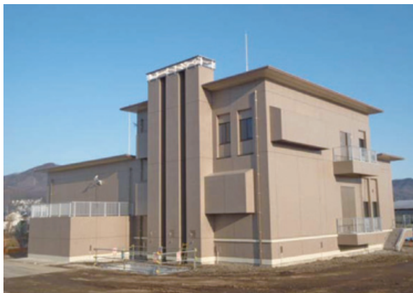
秦野市大根川ポンプ場
