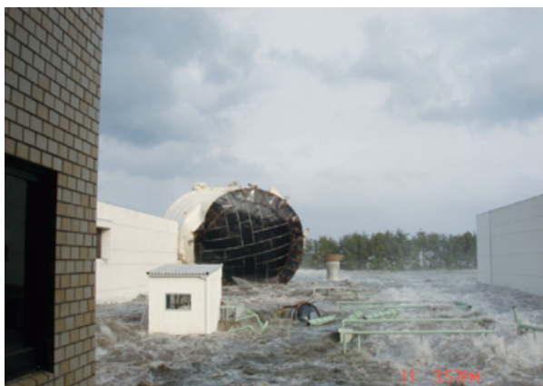
写真－3 3:57 一気に水位が上昇しガスタンクが転倒し流れ出す
