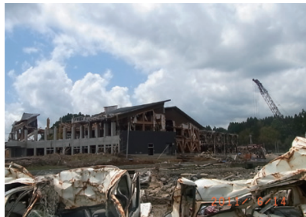
北上総合支所東側から
