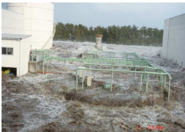
写真－2 3:57 津波により濃縮槽が水没
