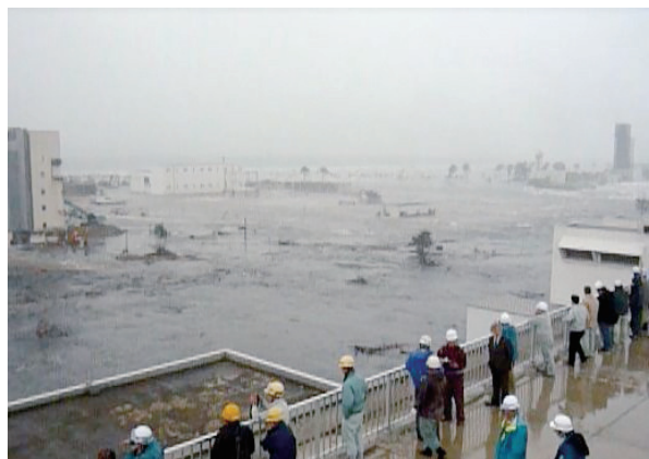
写真-10 最初沈殿池が水没
