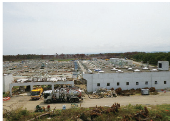
写真－6 被災後の水処理施設（後日撮影）
