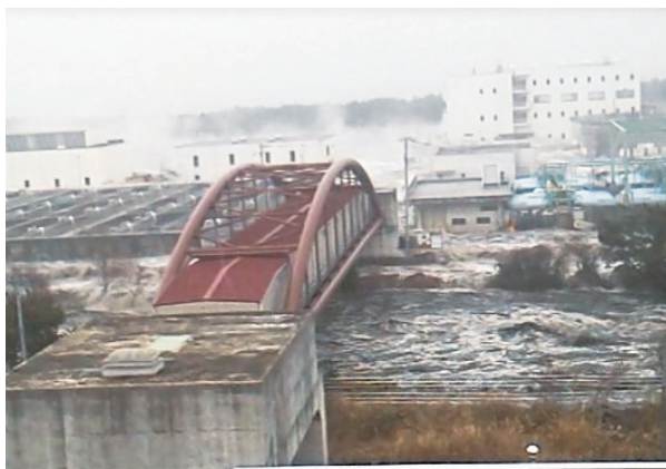
写真-7 管理棟屋上から反応槽を撮影
