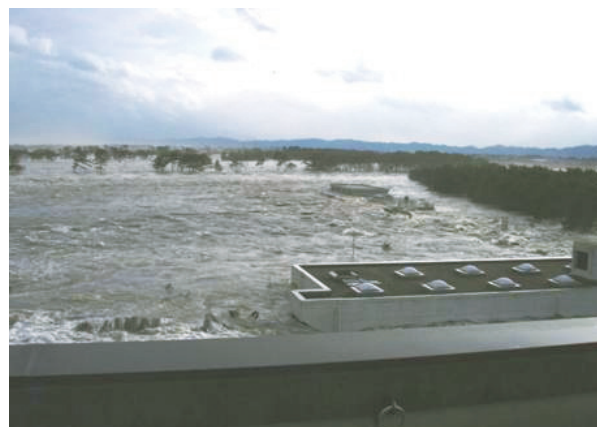
写真－5 被災当日の水処理施設の水没状況
