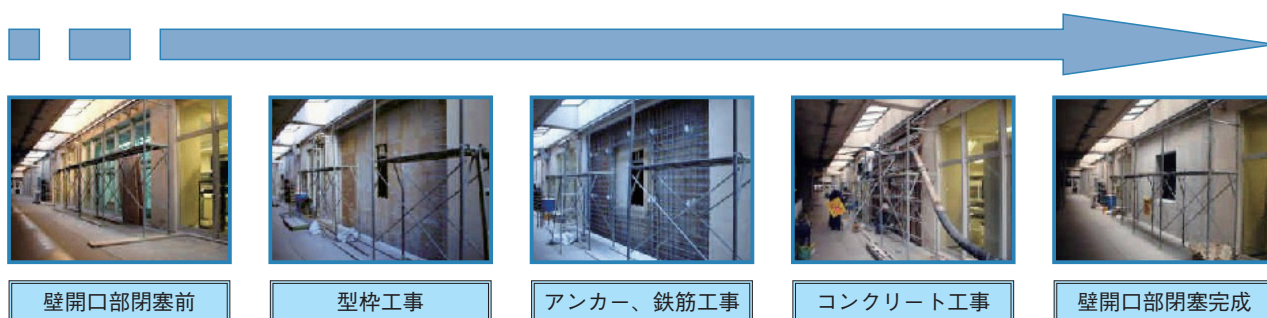
図－４ 耐震改修の事例
