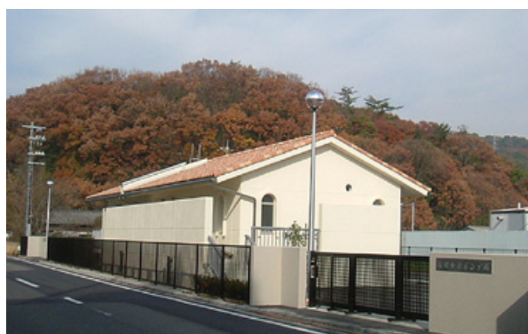
岡山県 玉野市後閑中継ポンプ場
