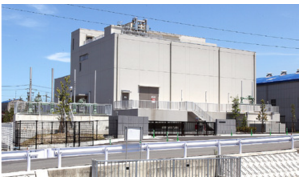
愛媛県 今治市鳥生排水ポンプ場
