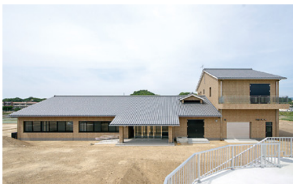
和歌山県 御坊市塩屋浄化センター
