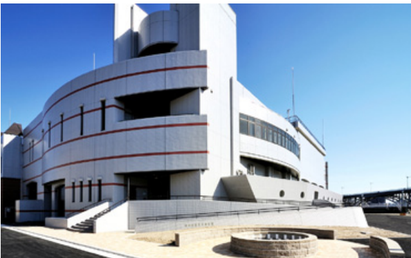
広島県 広島市新千田ポンプ場
