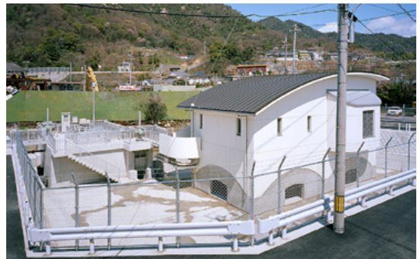
広島県 坂町藤之脇雨水ポンプ場
