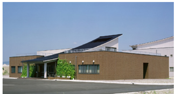
徳島県 旧吉野川流域下水道旧吉野川浄化センター
