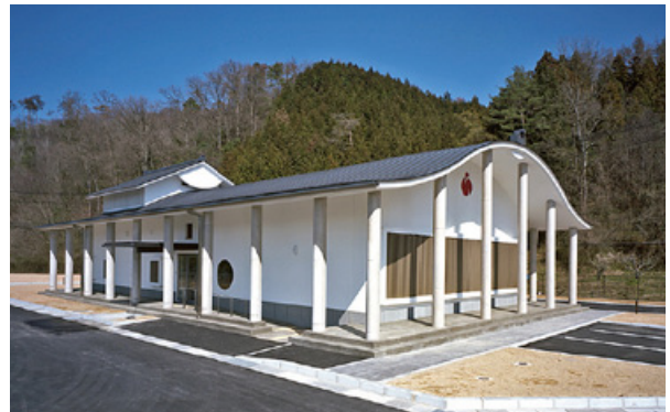
広島県 世羅町甲世浄化センター
