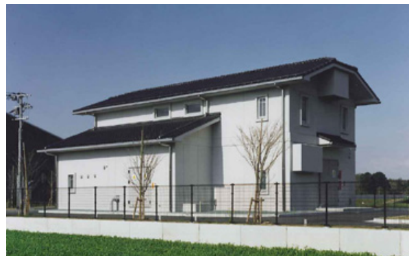
福岡県 久留米市上津中継ポンプ場
