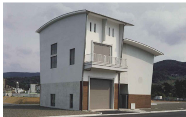
長崎県 松浦市松浦浄化センター
