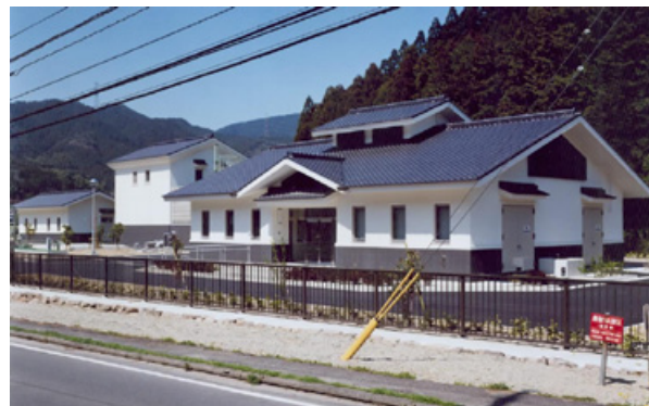
福岡県 朝倉市秋月浄化センター
