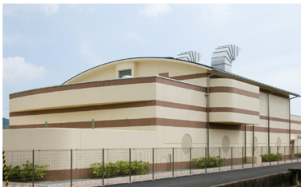
兵庫県 洲本市物部ポンプ場
