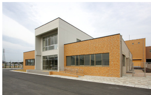
福岡県 新宮町中央浄化センター
