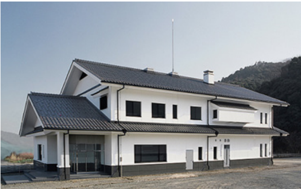
京都府 京丹後市網野浄化センター
