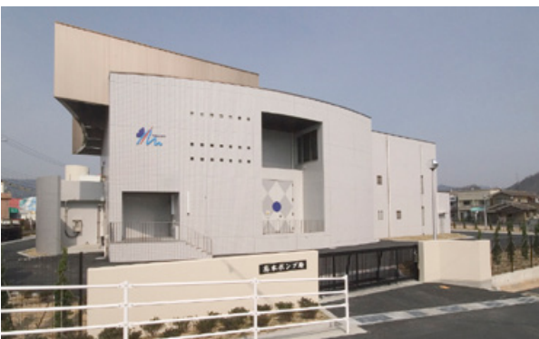
広島県 府中市高木ポンプ場
