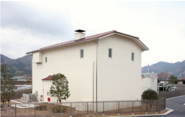
岡山県 真庭市中島北雨水ポンプ場
