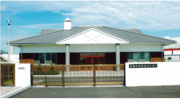
岡山県 瀬戸内市長船中央浄化センター
