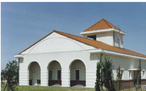
福岡県 行橋市行橋浄化センター
