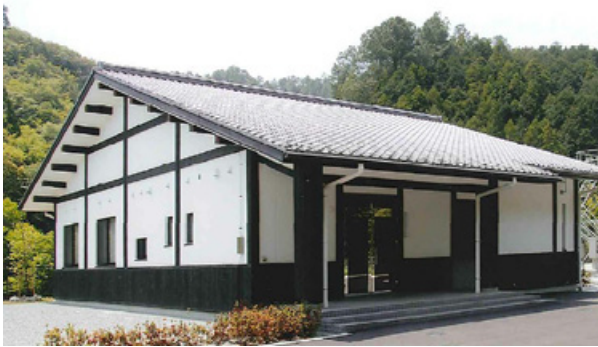
徳島県 海陽町穴喰浄化センター
