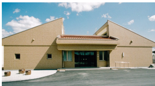
島根県 大田市大田浄化センター
