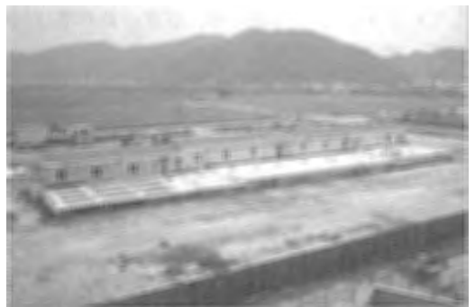
岡山市吉井川浄化センター
