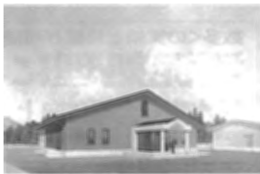
中之条町中之条浄化センター 管理棟
