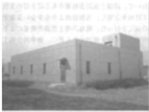
神通川左岸流域下水道 神通川左岸浄化センター建設工事その9
