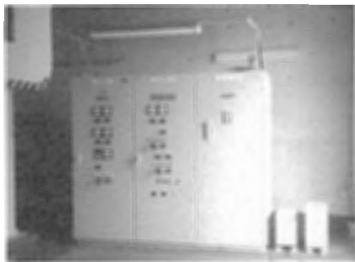
鬼怒川上流流域下水道 南第3中継ポンプ場電気設備工事
