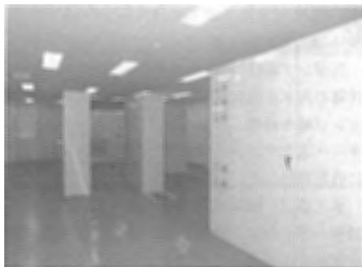
津南町津南浄化センター電気設備工事
