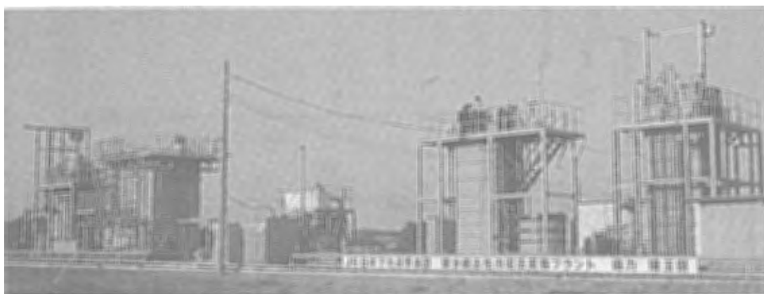
図-3 共同研究パイロットプラントの外観
