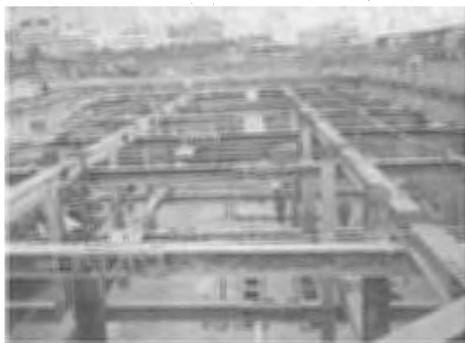
大分市南部污水中継ポンプ場建設工事
