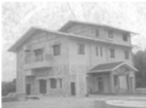
阿児町神明浄化センター建設工事
