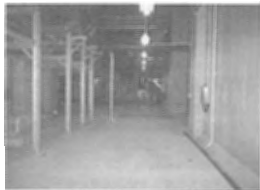
児島湖流域下水道浄化センター 水処理設備工事その12
