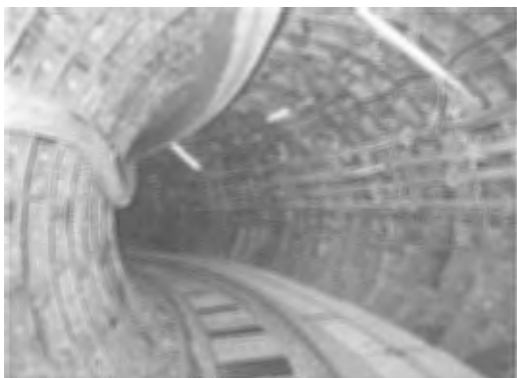
倉敷市倉敷1号幹線建設工事その14
