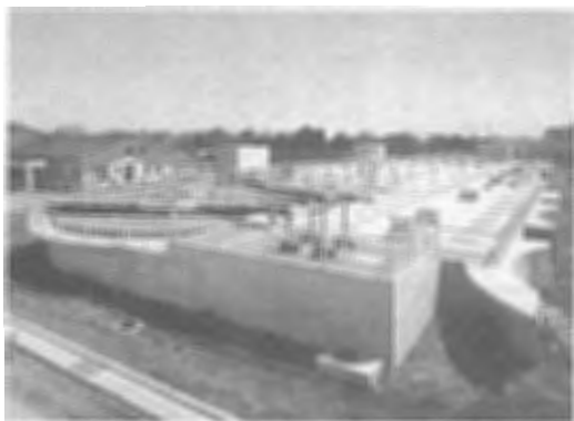
宇都宮市清原処理場水処理設備工事
