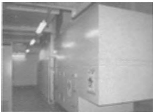
葉山町葉山中継ポンプ場自家発電設備工事
