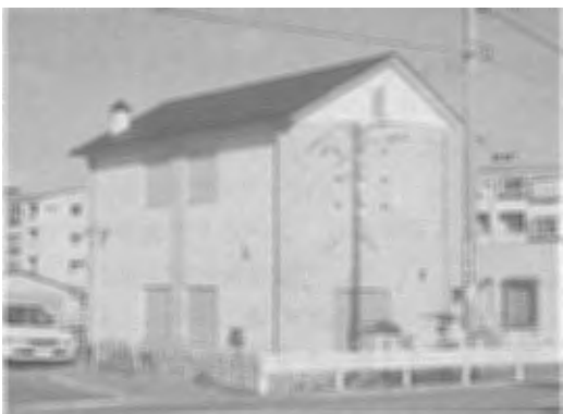
久留米市宮ノ陣中継ポンプ場建設工事
