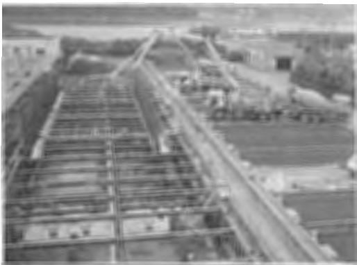
臼杵市臼杵終末処理場建設工事その9
