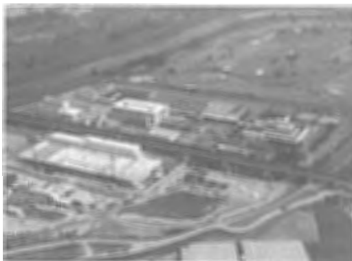
高崎市阿久津下水処理場建設工事その3
