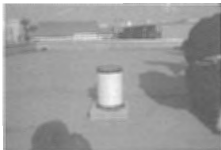
写真-1 雨量計設置状況
