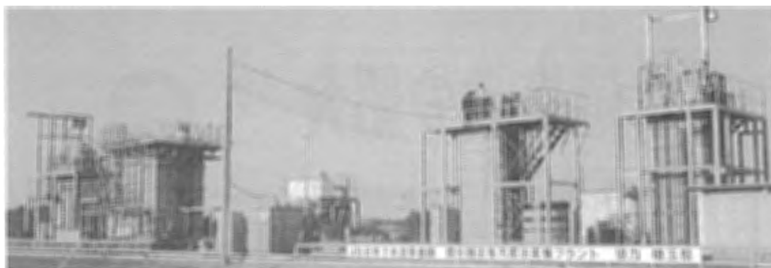
写真—1 膜分離活性汚泥法の実用化研究共同実験プラント
