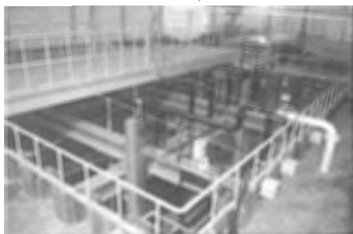
写真－６ 温泉地区仮設下水終末処理場 (池槽に鋼矢板)
