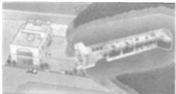
トンネル式下水処理
