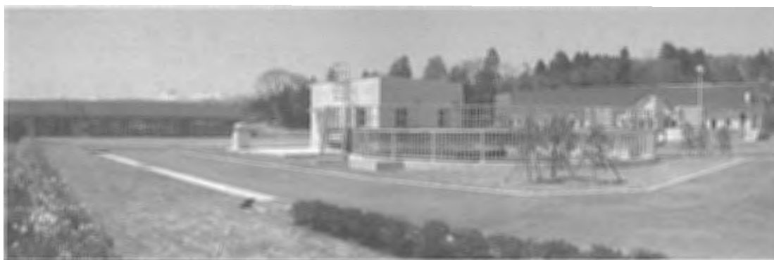
写真－1 完成した七戸町浄化センター 東北新幹線の融雪試験装置（左の高架）、その奥には八甲田山系が望める。
