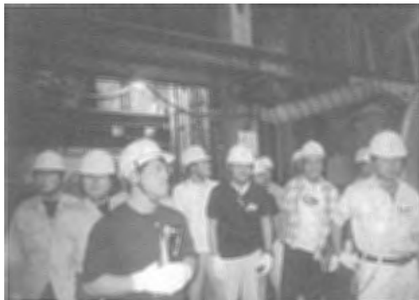
施設見学にて、東京都のシールド工事の現場に入りました。
