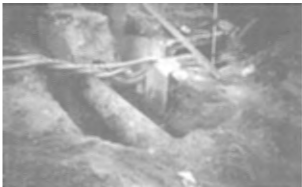
破壊した初沈流入きょと六甲流入管
