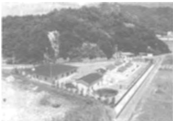
大三島町宮浦浄化センター
