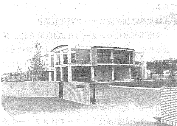
武蔵東部浄化センター
