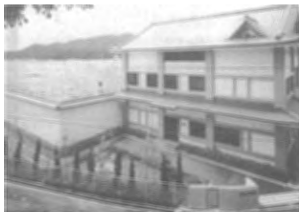
兵庫県御津町室津浄化センター
