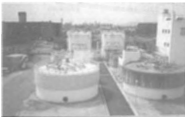
6. 宇治市東宇治浄化センター建設工事その14
