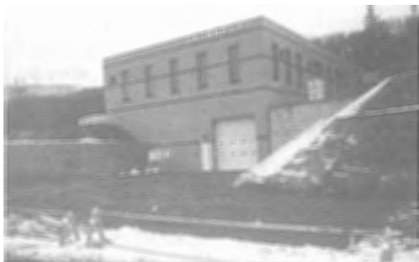
1. 泊村泊地区浄化センター建設工事
