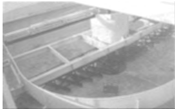
14. 徳島市北部浄化センター水処理設備工事その 3
