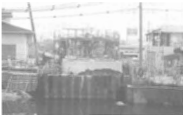
7. 水俣市水俣百間雨水ポンプ場建設工事
