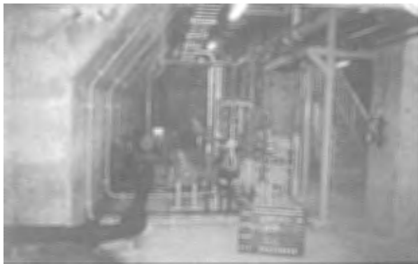
11. 佐久下水道組合佐久終末処理場水処理設備工事その 3
