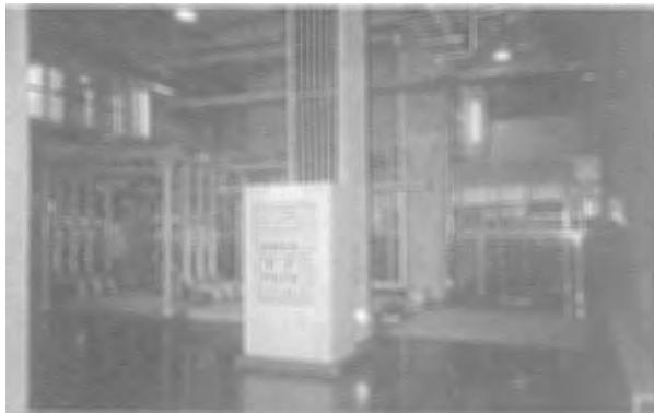
10. 柏崎市自然環境浄化センター水処理設備工事その 6
