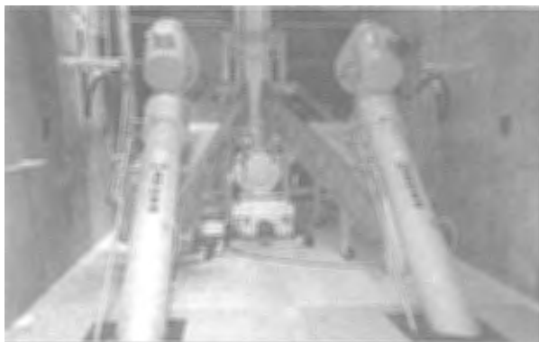
12. 宇土市宇土終末処理場水処理設備工事その 5
