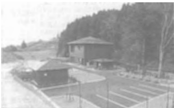
3. 須賀川市(仮称)テクニカルリサーチガーデン浄化センター建設工事
