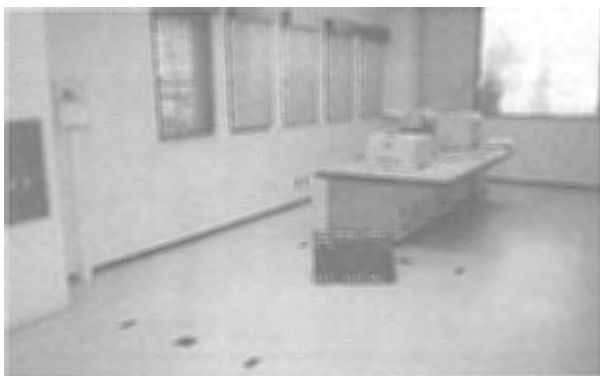
17. 松前町松前浄化センター電気設備工事
