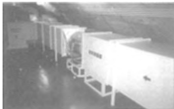
16. 岩手町沼宮内中継ポンプ場電気設備工事
