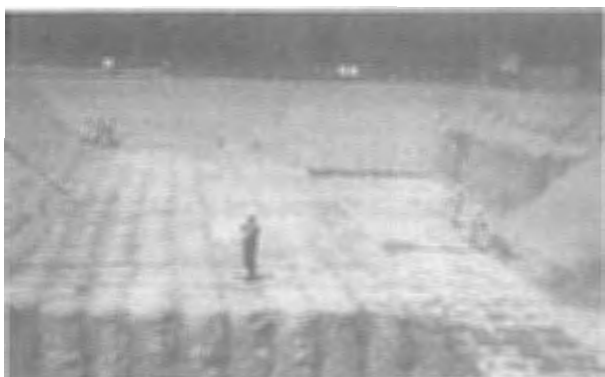
4. 本荘市本荘終末処理場建設工事その13
