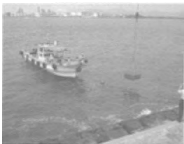
写真-6 テストブロックの設置
