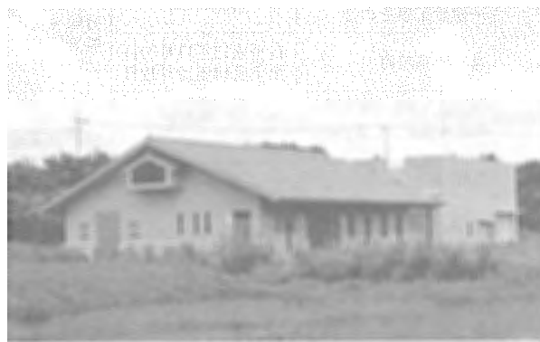
7. 高崎町高崎浄化センター建設工事その2
