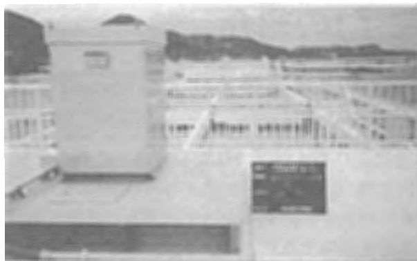
9. 安浦町安浦浄化センター水処理設備工事その3
