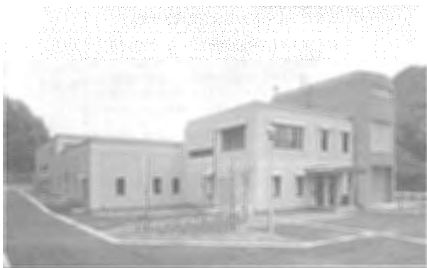
2. 湯田町湯田浄化センター建設工事
