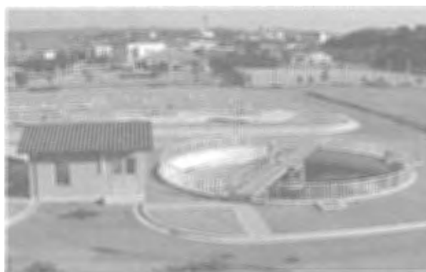
5. 庄原市浄化センター建設工事その3
