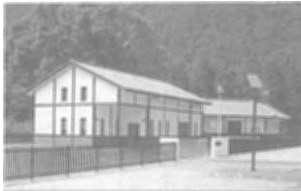
6. 大山町浄化センター建設工事
