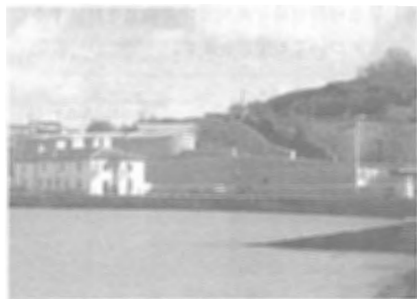
写真一1 海外の大規模膜分離活性汚泥法 下水処理場（英国13,000m 3 /日）
