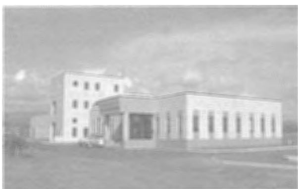
1. 今金町今金浄化センター建設工事その2
