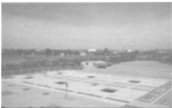
3. 大沢野町大沢野浄化センター建設工事その7
