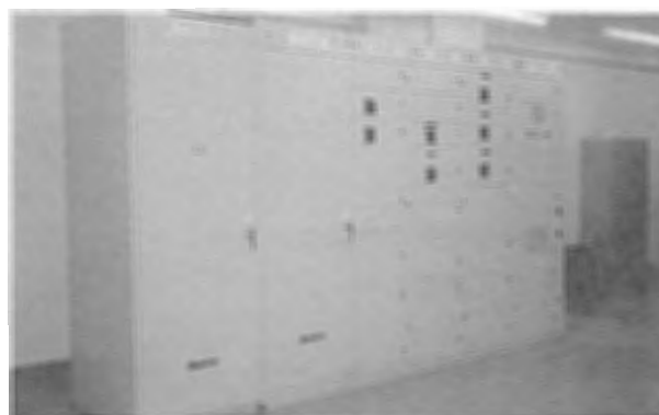
13. 大崎町大崎クリーンセンター電気設備工事
