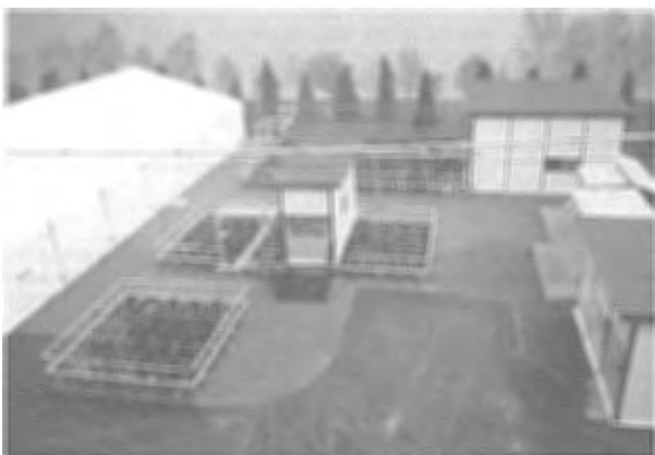
有珠山噴火（H12）：災害復旧の受託により鋼矢板を利用した仮設の処理場を建設
