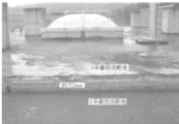
新潟中越地震（平成16年10月）：被災状況
