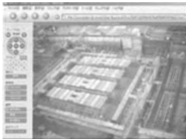
図－2 インターネット技術を利用した現場のカメラ監視事例
