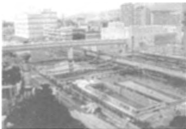
阪神淡路大震災（H7）：J S 提案支援により運河を利用した仮設処理場を設置
