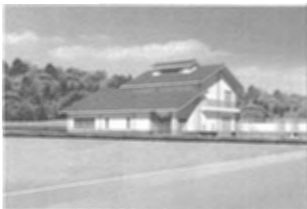
大原浄化センター
