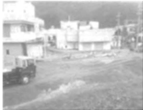
豊岡市浄化センターの被災後の仮復旧状況写真
