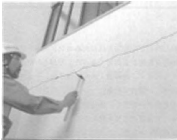
写真二 目視による劣化状況の確認
