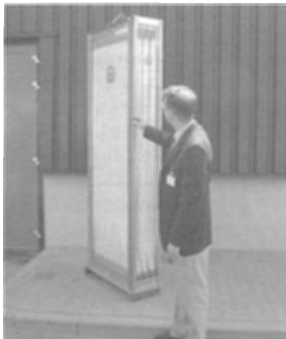
写真－４ ファッセフェルド処理場膜ユニット
