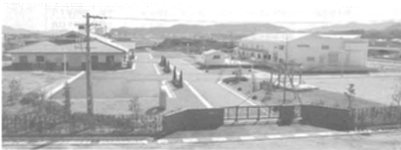
写真-1 福崎浄化センター全景（右が水処理棟）
