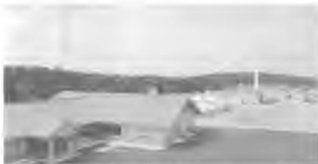
大須賀浄化センター全景
