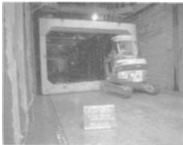
写真－２ ボックスカルバート搬送状況
