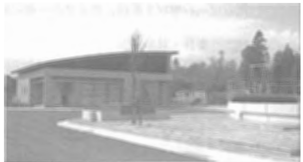
江田島市（旧大柿町）大柿水質管理センター
