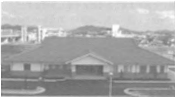
兵庫県福崎町福崎浄化センター 管理棟
