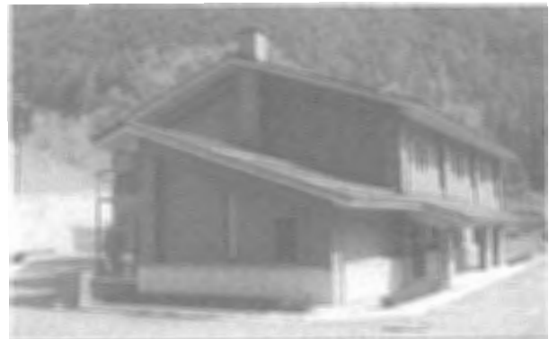
下呂市南部浄化センター（西南面より撮影）
