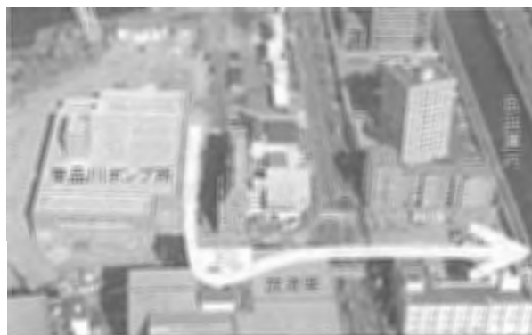
写真一 1 施工箇所状況
