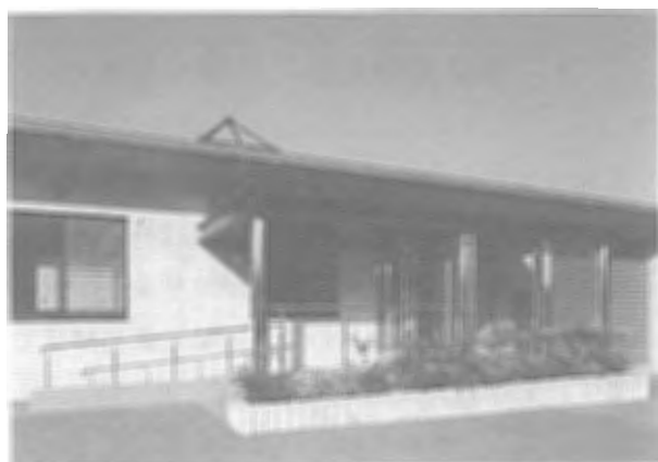
愛媛県今治市（旧大三島町）宮浦浄化センター
