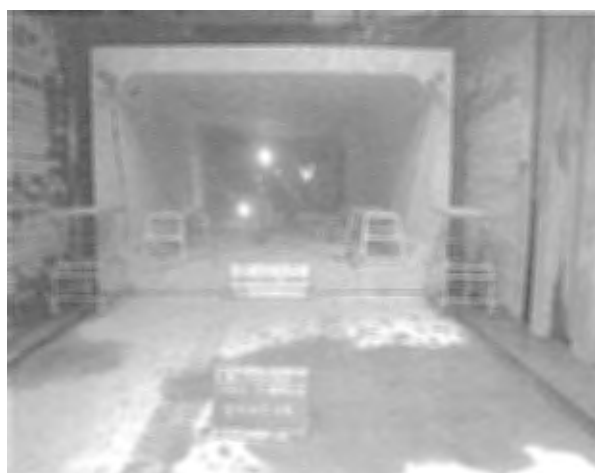
写真－３ ボックスカルバート定着状況
