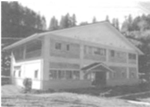
梶原浄化センター
