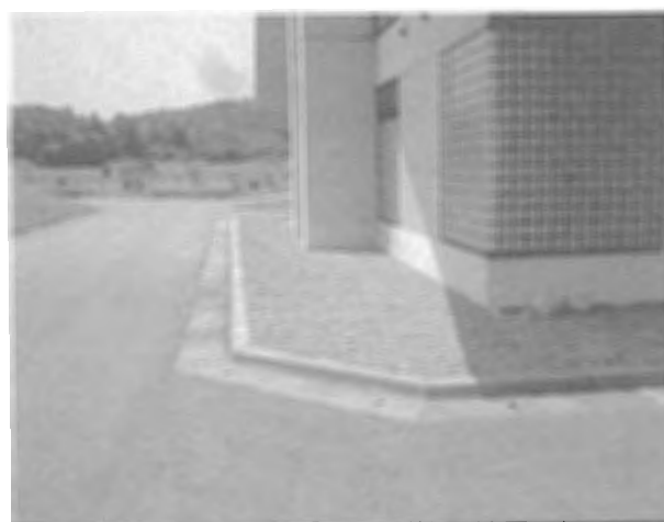
写真-4 碎石敷設状況(管理棟周辺)
