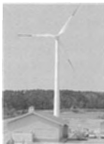
写真－２ 風力発電設備
