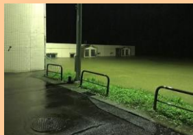
浸水状況(場内)
