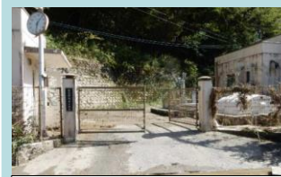
浸水状況(場内)
