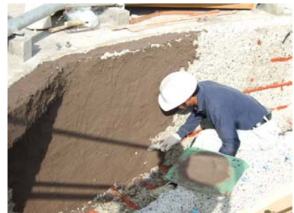
写真 1 耐硫酸モルタル防食工 試験施工 実施状況
