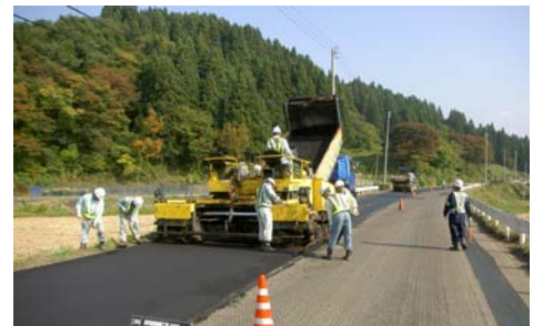
実路における試験舗装状況
