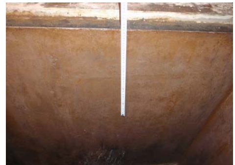
写真-1 試験施工箇所確認状況
