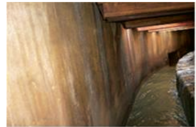
写真-1 施工箇所状況
