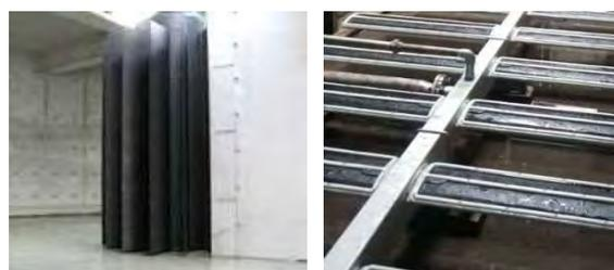
縦軸水流発生装置付散気式曝気装置
