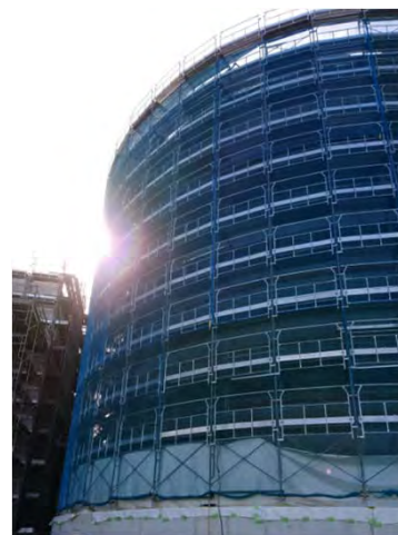
鋼板製消化タンク本体の建設状況
