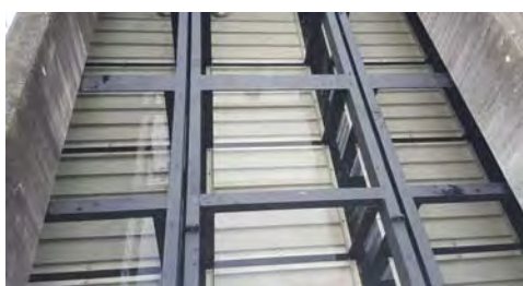
ろ材部設置状況写真
