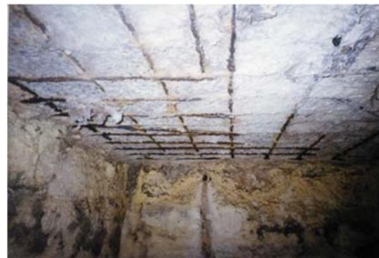
硫酸によるコンクリート構造物の腐食事例
