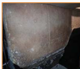
処理場F（好気槽上流側）の躯体状況（↓表面脆弱化）
