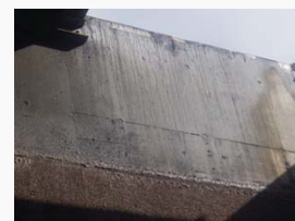
処理場F（好気槽上流側）の躯体状況（↓表面脆弱化）
