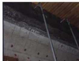
処理場F（好気槽上流側）の躯体状況（↓表面脆弱化）
