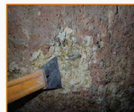
処理場F（好気槽上流側）の躯体状況（↓表面脆弱化）
