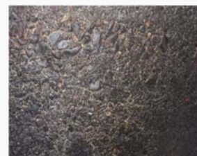
処理場D（好気槽下流側）の躯体状況（表面脆弱化）
