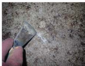
処理場C（好気槽中流）の躯体状況（表面脆弱化）
