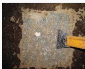
処理場C（好気槽中流）の躯体状況（表面脆弱化）
