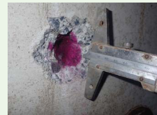
劣化状況調査の例（中性化深さ測定）
