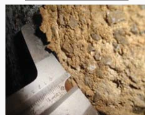
処理場D（好気槽下流側）の躯体状況（表面脆弱化）
