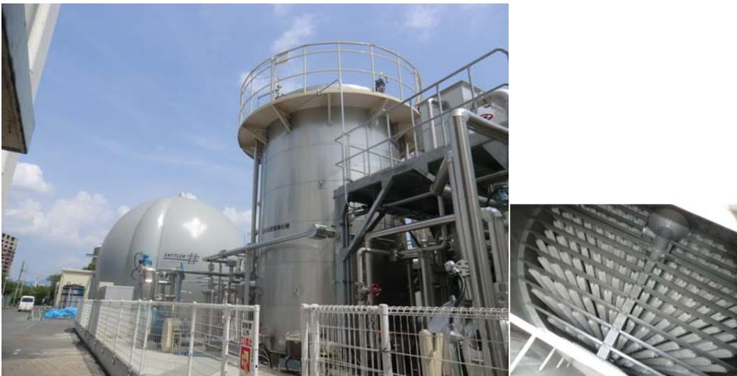
担体充填型消化タンク実証試験施設と担体の充填状況（大阪市中浜処理場内）
