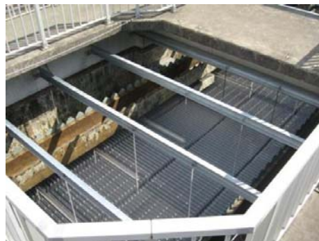
写真2 傾斜板の設置
