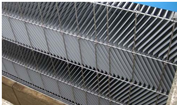
写真1 傾斜板の構造
